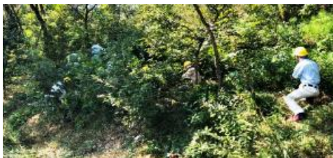
里山風景区の林床整備
